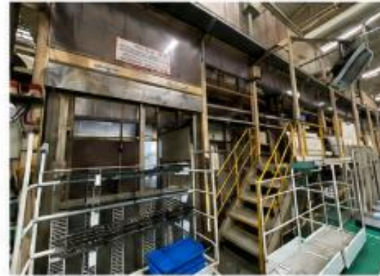
มุมมองด้านหน้า (ด้านทางเข้า)
